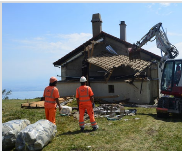
Travaux de démolition et rénovation de 2020
